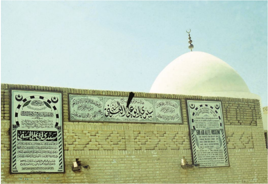
الصورة عدد 1: الواجهة الأمامية لزاوية سيدي بوعلي بنفطة
