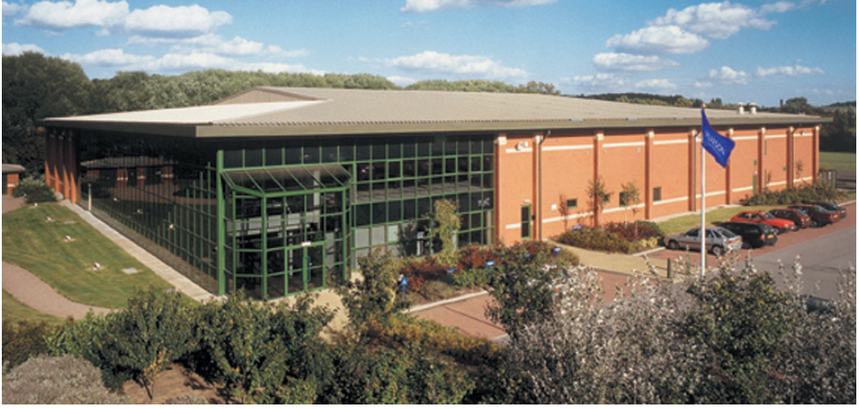
الشكل (5) مبنى التصحيح الإلكتروني التابع لشركة بيرسون Pearson Company
