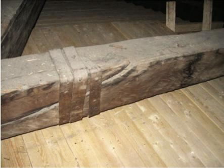
مرباط ومشدات حديدية قديمة لتدعيم الهيكل الخشبي للسقف، أثناء الترميم
